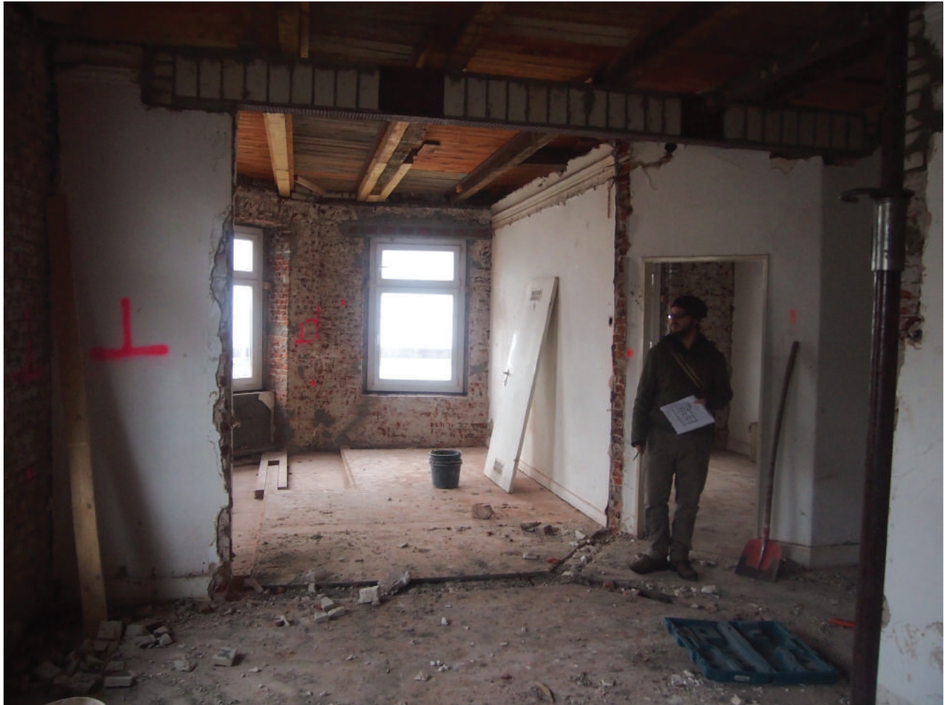
Jonas bei der regelmäßigen Baubegehung. Aus drei mach eins. Hier entsteht ein großer Gemeinschaftsraum.
